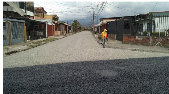
Imagen 5 Proceso de Colocación TSB3 UNEMOPT
