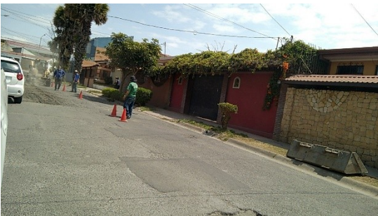
Imagen 2 Trabajos de perfilado en C-1-14-021 Colegio Las Américas Súper Ángela
