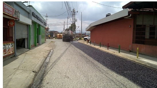
Imagen 4 Proceso de Colocación TSB3 UNEMOPT
