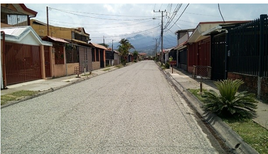
Imagen 3 Proceso de Colocación TSB3 UNEMOPT
