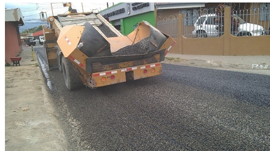
Imagen 6 Proceso de Colocación TSB3 Detras de la plaza de deportes
